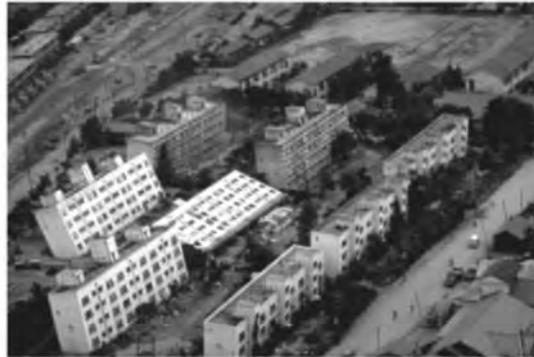
**Figura 1.4 - Edificios inclinados por licuación de arenas**
